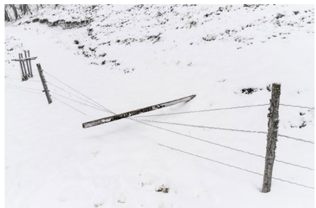
Ce câble de clôture (ondulé 1 x 7, 3,3 mm) a été spécialement conçu par la société Kuert Seilerei à Langenthal. Le prix d'achat très élevé est compensé par la très faible maintenance qu'il nécessite et son caractère respectueux des animaux.
