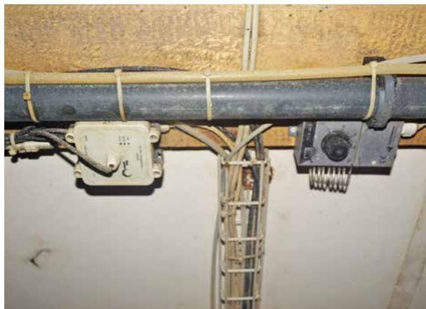
*Les câbles posés de façon apparente sont facilement accessibles et sont moins attaqués par les rongeurs.*
