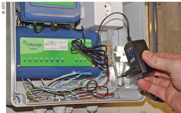
Les systèmes d'alarme vers un téléphone portable sont sur batterie et doivent être régulièrement testés.
