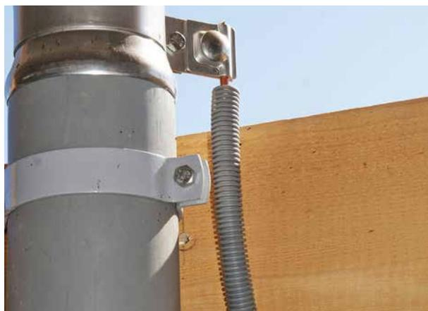
*Fils de cuivre dissipateurs, gainés sous tubes ignifugés.*
