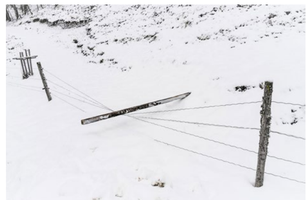
Die Weidezäunlitze (gewellt 1 x 7, 3,3 mm) ist eine Spezialanfertigung der Firma Kuert Seilerei in Langenthal. Die recht hohen Anschaffungskosten werden kompensiert durch einen extrem tiefen Unterhaltsbedarf sowie eine gute Tierfreundlichkeit.
